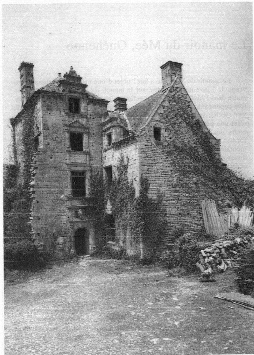
Élévation antérieure sud. État en 1991 avant restauration. (Cl. Inventaire Général, Artur-Lambart)
