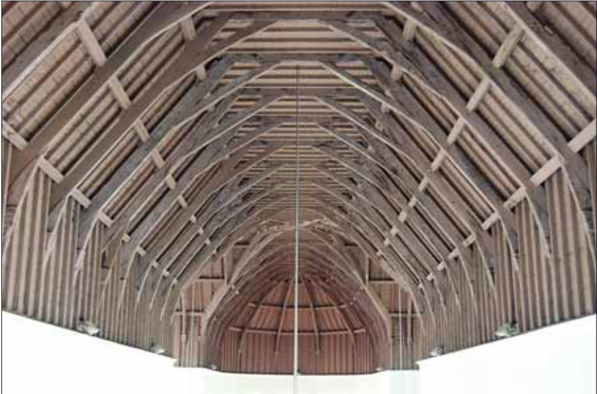
Figure 3 – La voûte actuelle, à partir de la charpente ancienne ; une mince corniche termine les murs peints en blanc
