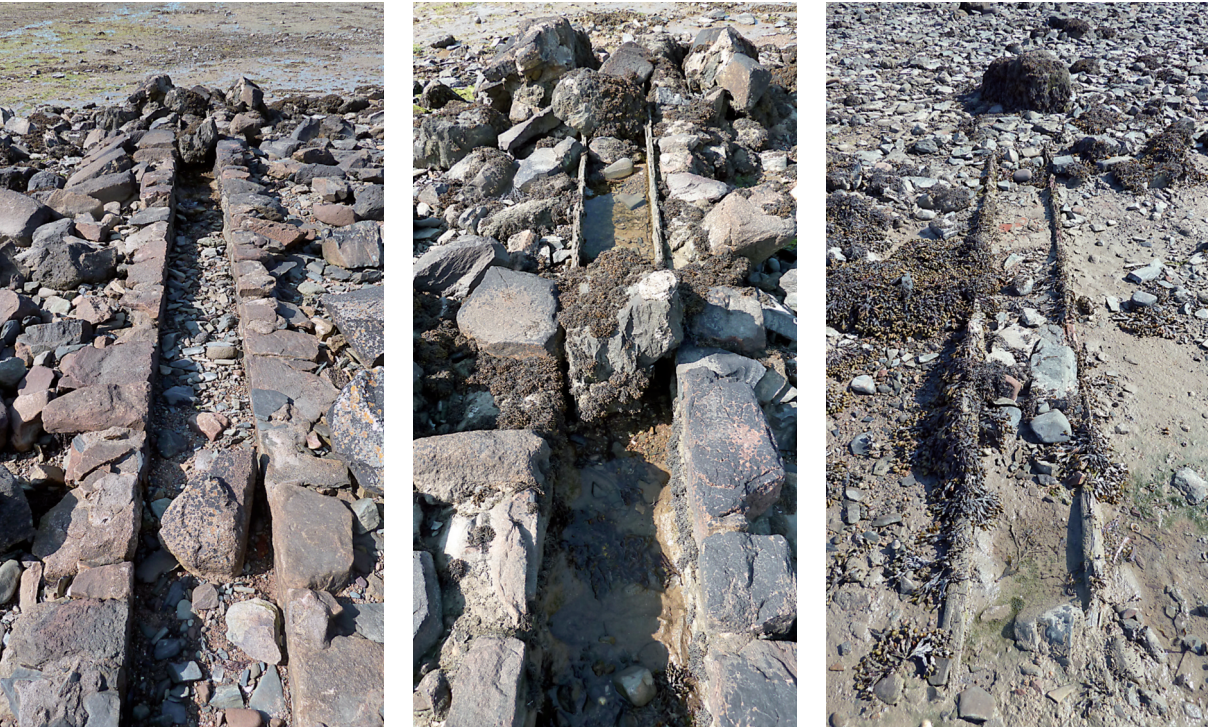
Figures 11a, b et c – Vues des conduites d'évacuation de l'étang salé (cl. Amis de Beauport)
