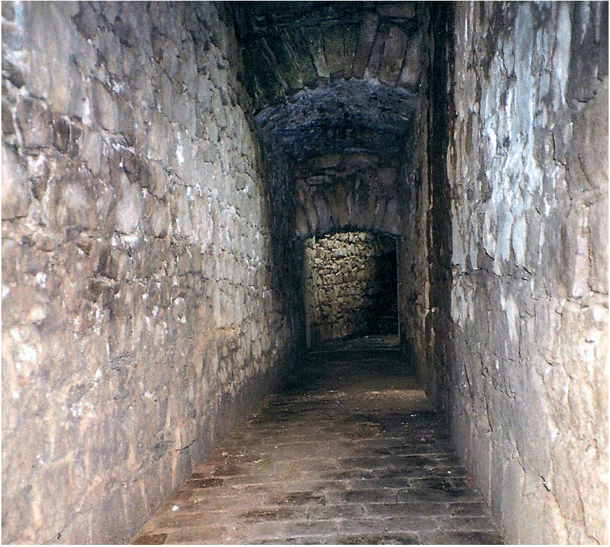
Figure 6 – Vue du canal du bâtiment au Duc (cl. Amis de Beauport)
