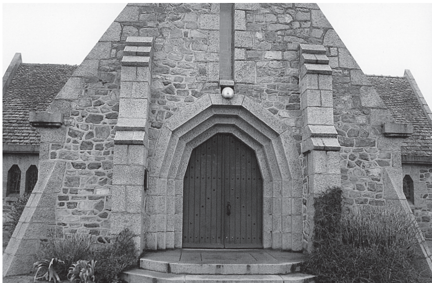
Photo 17 – Polyolithisme maîtrisé. Église de Loguivy. Les pierres de taille sont en granite rougeâtre de La Clarté à Ploumanac’h ; les moellons en granodiorite et en micro-granite de provenance locale (cl. L. Chauris, 25 février 2012)
