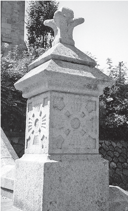
Photo 14 – Église de Plouézec. Granite de l'Île-Grande en pierres de taille soigneusement appareillées
