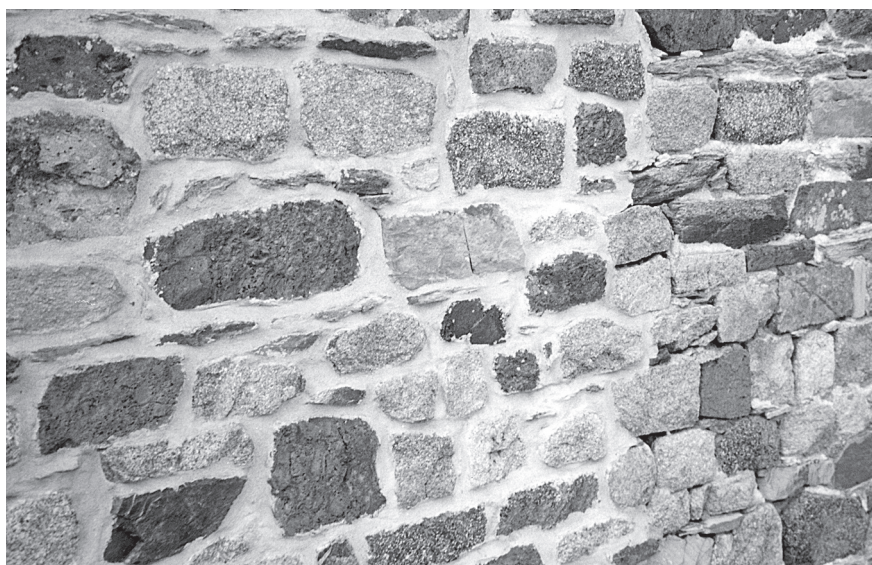
Photo 18 – Élévation méridionale de l’église à Lézardrieux. Polyolithisme exacerbé (spilite de Paimpol, « gabbro » de Keralain, granodiorite type Bréhat...) (cl. L. Chauris, 7 juin 2005)
