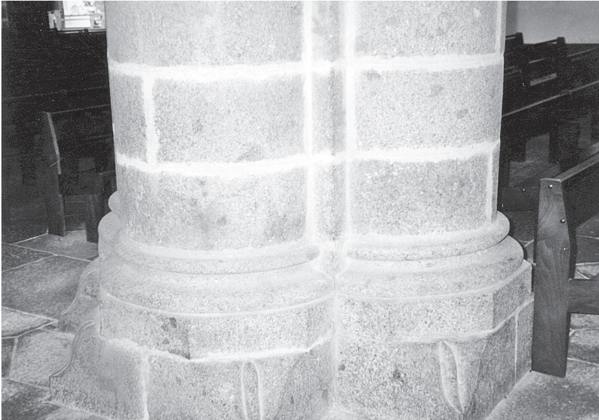
Photo 10 – Pilier du transept dans l'église de Plouha en granodiorite locale à enclaves (cl. L. Chauris, 27 mars 2002)
