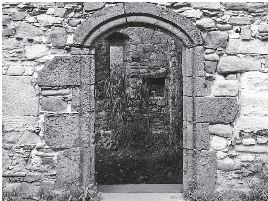
Photo 6 – Abbaye de Beauport. Porte en « tuffeau vert » dans le réfectoire ; murs en moellons gréseux hétérométriques (cl. L. Chauris, 19 mai 2004)
