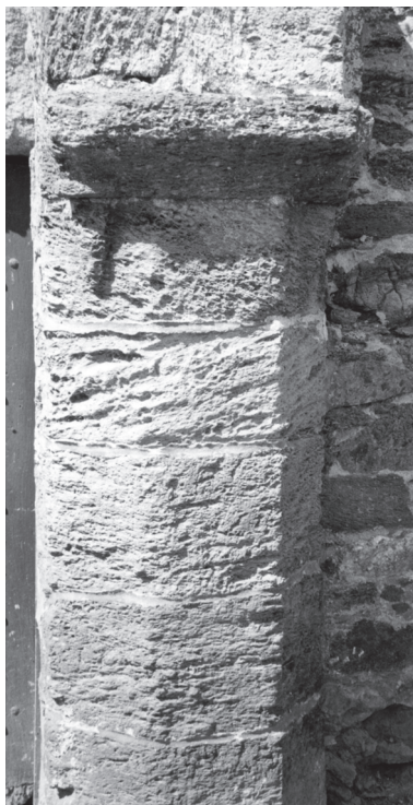
Photo 1 – Dans l’ancienne église de Paimpol, colonne en splite très érodée (cl. L. Chauris, 8 juin 2005)
