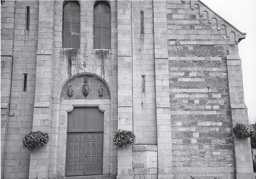
Photo 14 – Église de Plouézec. Granite de l'Île-Grande en pierres de taille soigneusement appareillées
