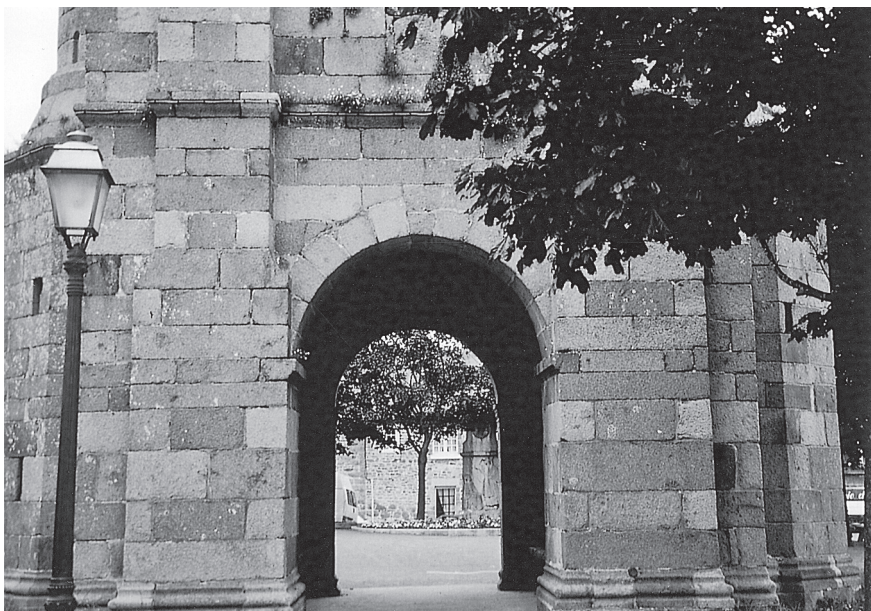
Photo 8 – Partie inférieure du clocher-porche de l'ancienne église de Paimpol ; large appel à la granodiorite de Bréhat en pierres de taille (cl. L. Chauris, 13 juin 2002)
