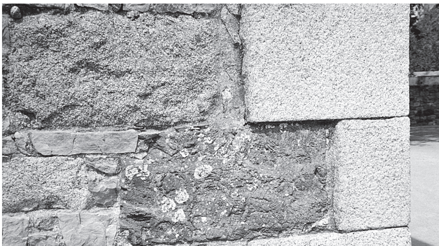
Photo 20 – Polyolithisme désordonné à l’église de Plourivo : au centre, gros moellon de spilite ; en haut, à gauche, grand moellon en granodiorite type Bréhat ; moellons hétérométriques en grès de Plourivo ; à droite, chaînage d’angle en pierres de taille façonnées dans le granite de l’Île-Grande (cl. L. Chauris, 7 juin 2005).
