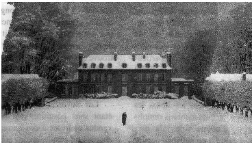
Figure 15 – Plouénan, château de Kerlaudy, vue du corps de logis depuis l'avant-cour, sur une photographie ancienne imprimée sur papier ; extraite d'un quotidien ? (coll. particulière) (cl. Joseph Montfort)
