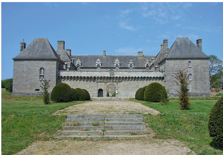
Figure 2 – Brélès, château de Kergroadès, vue du côté de l'entrée (sud-est) (cl. G. Floc'h)
