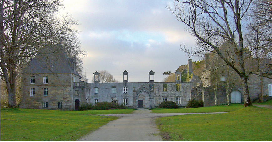
Figure 3 - Guilers, manoir de Keroual, vue du côté de l'entrée (sud ; sud-est) (cl. G. Floc'h)
