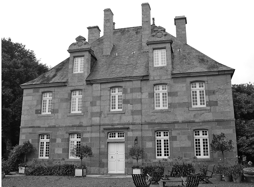
Figure 10 – Cléder, « grand pavillon » de Kergournadeac'h, vue de la façade antérieure (sud) du corps de logis (cl. G. Floc'h)
