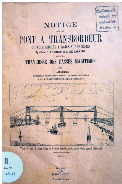
Figure 3 – ARNODIN, Ferdinand, Notice sur le pont à transbordeur (Arch. dép. Loire-Atlantique, Br-in 8° 1347)
