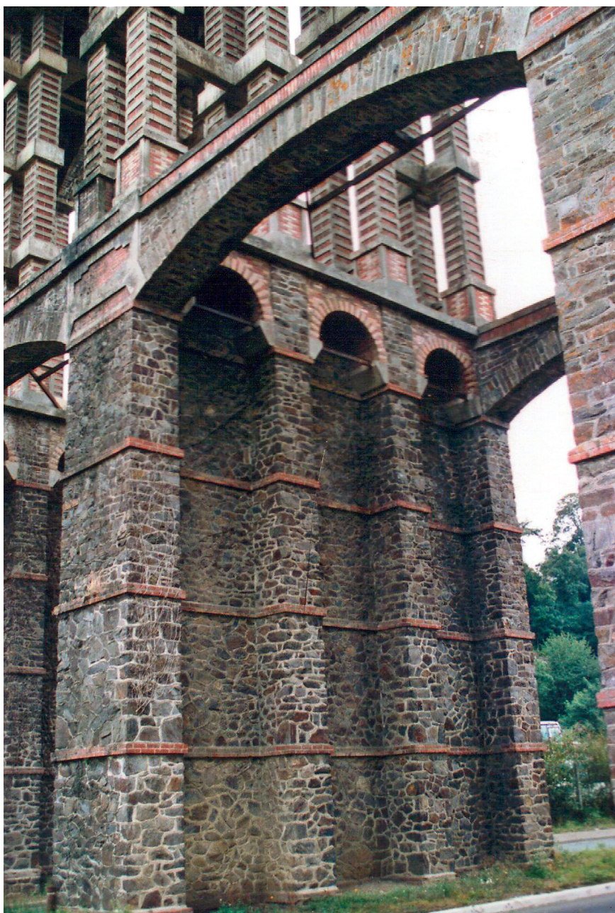
Figure 9 – Saint-Brieuc, viaduc de Souzain, piles (cl. G. Le Louarn, septembre 1990)
