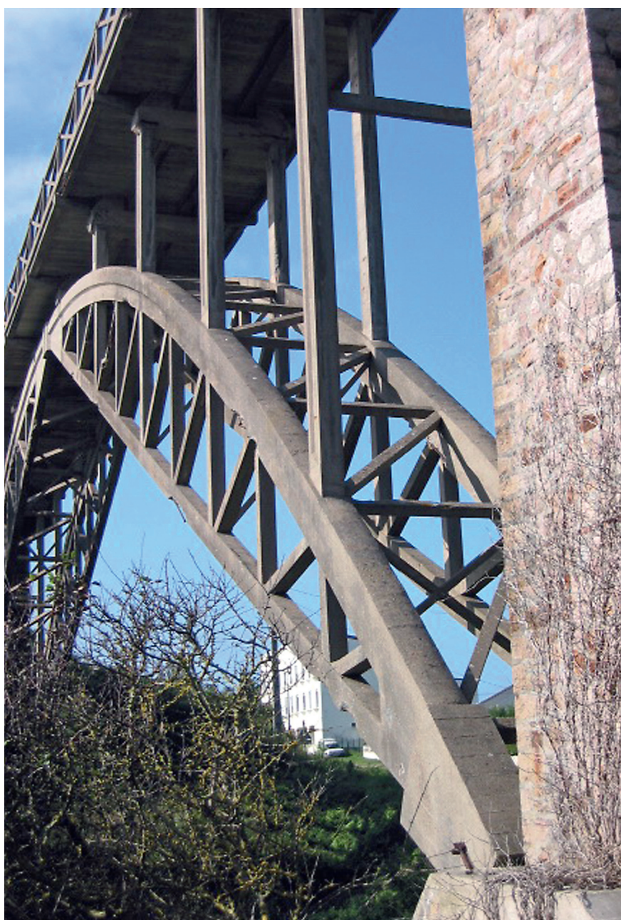
Figure 12 – Erquy, viaduc de Caroual (cl. G. Le Louarn, mai 2010)
