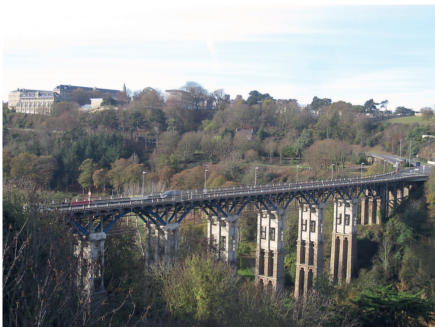
Figure 7 – Saint-Brieuc, viaduc de Toupin (cl. G. Le Louarn, novembre 2011)
