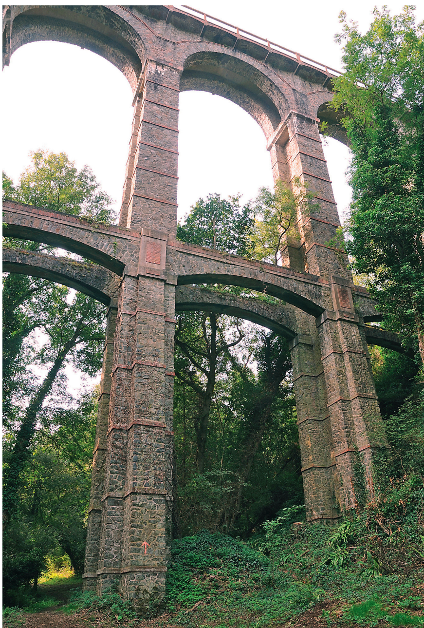
Figure 3 – Plérin, viaduc du Parfond de Gouët (cl. François Lépine)
