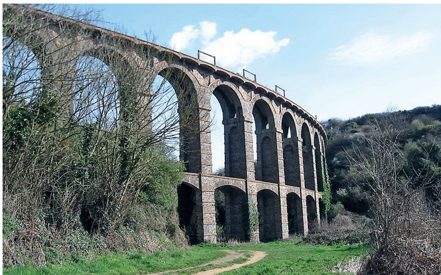
Figure 4 – Saint-Brieuc, viaduc de Douvenant (cl. G. Le Louarn, mai 2010)
