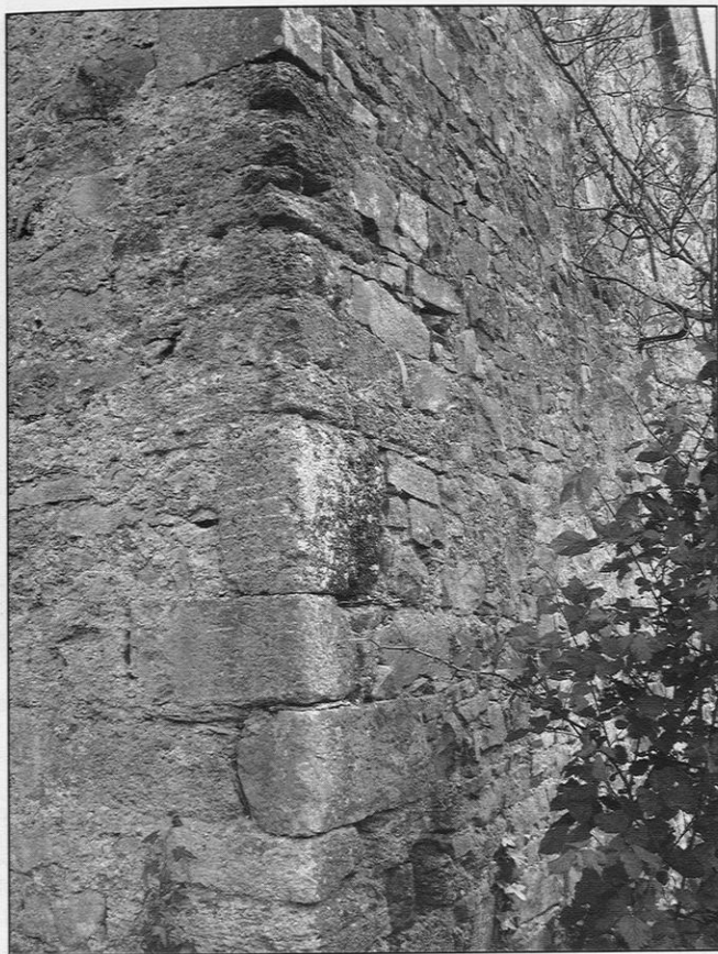
Figure 9. – La Bouëxière, Rallion, angle nord-ouest de la nef (JCM).
