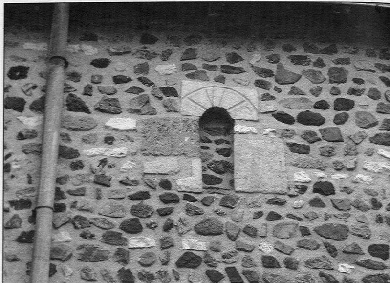
Figure 20. – Ruillé-Froid-Fonds, Saint-Gervais-et-Saint-Protais, mur sud de la nef (JCM).
