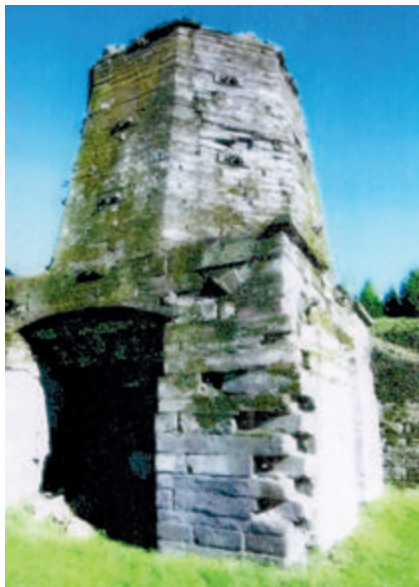
Figure 22 – Haut-fourneau des forges de Paimpont en grands éléments schisteux
