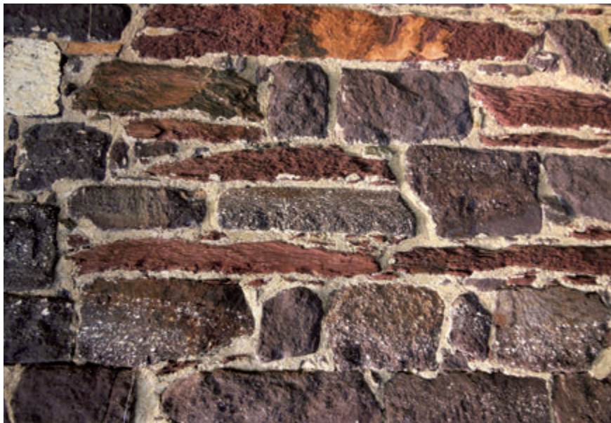
Figure 9 – Église d’Iffendic, élévation méridionale, poudingue et grès de Montfort ; schiste rouge en moellons plats très allongés (cl. L. Chauris)
