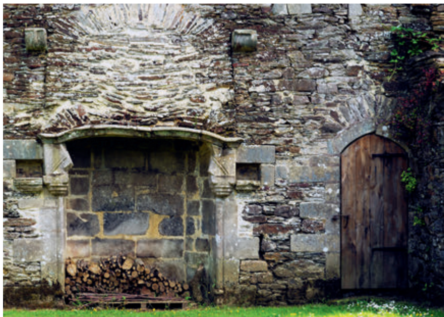
Figure 15 – Logis 1, la grande cheminée de la salle basse (cl. G. Meirion-Jones, 24 juin 2015)
