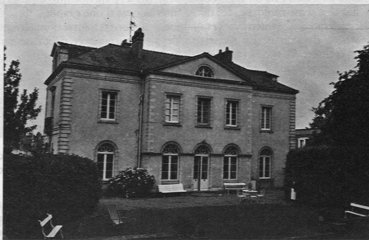
Fig. 4. La sous-préfecture de Redon (1839-1844), façade postérieure, Louis Richelot.
