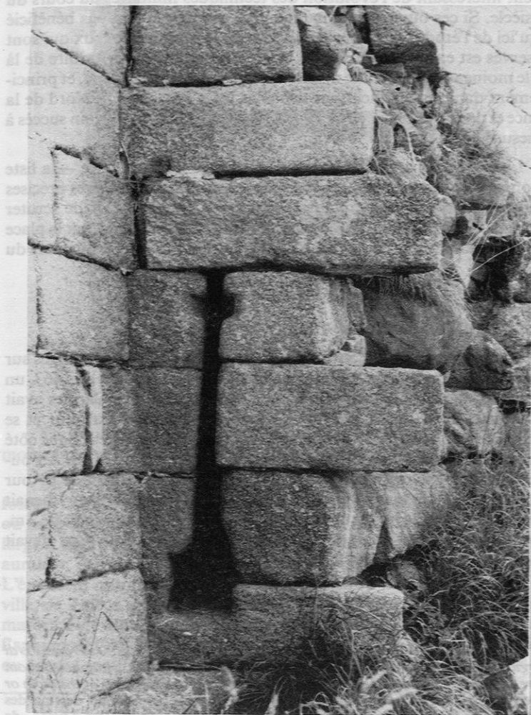
Vestiges du moineau du château de Tonquédec Flanc droit percé d'une archère-canonnière à bêche.
