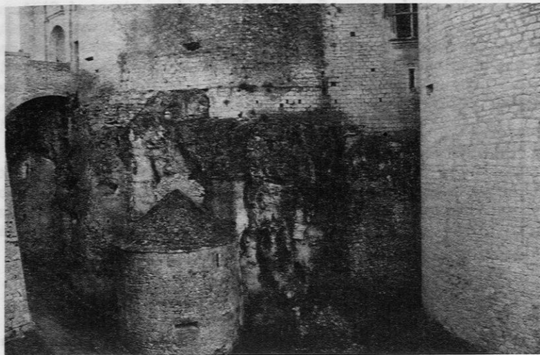
Bonaguil, château. Moineau dans les fossés entre la grosse tour (à droite) et la porte visible à l'extrémité gauche (en haut).
