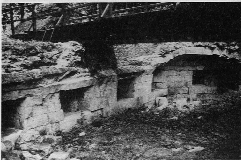
Vestiges d'un des moineaux du château de Loches.
