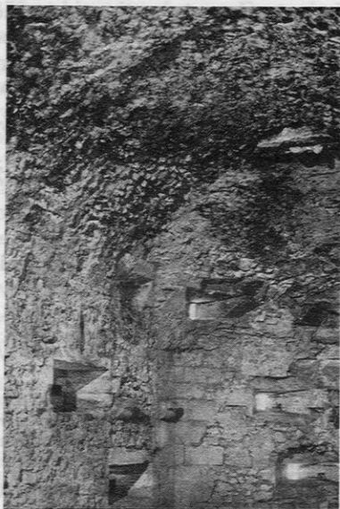
Bridoré, château. Vue interne d'un moineau. On remarque les ouvertures superposées des embrasures de tir.
