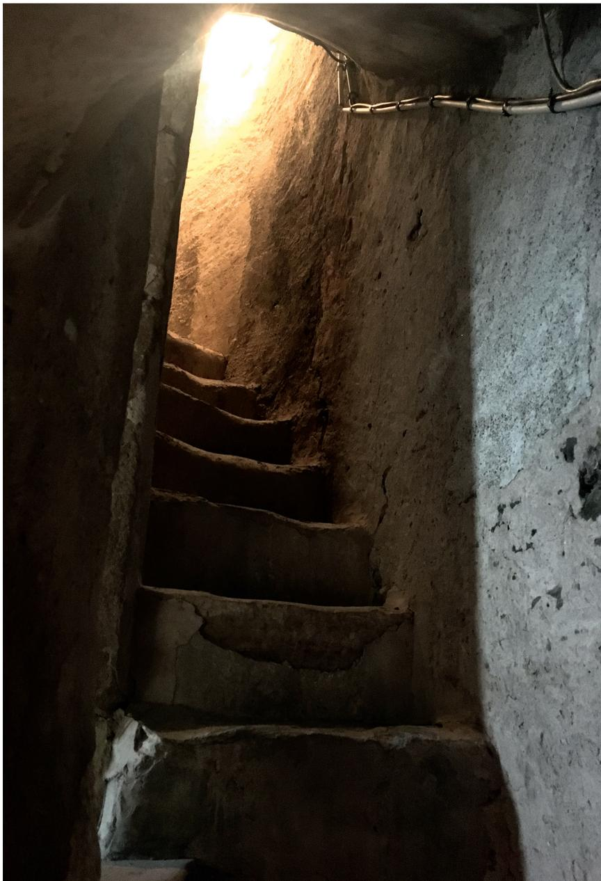
Figure 7 – Pornic, le château, vue de l'escalier rampant pris dans l'épaisseur du mur de la tour nord-ouest, entre le troisième étage et la terrasse (cl. J. Martineau)
