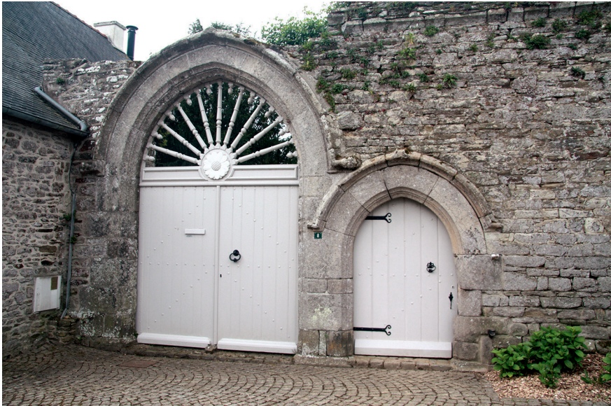
Figure 6 – Minihy-Tréguier, la Chapellenie, mur de clôture (cl. G. Le Louarn-Plessix)
