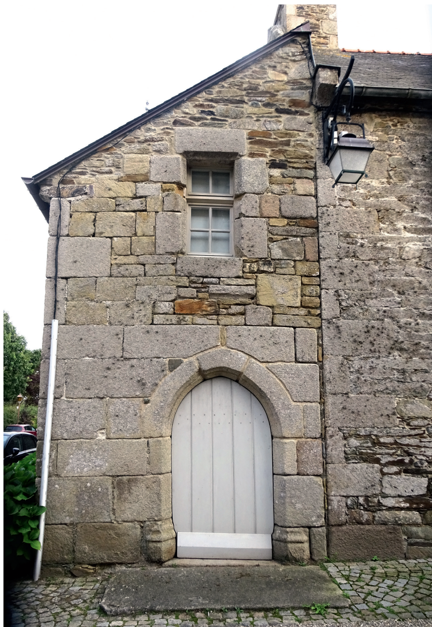
Figure 10 – Minihi-Tréguier, la Chapellenie, « l'appartement » vu du nord (cl. G. Le Louarn-Plessix)
