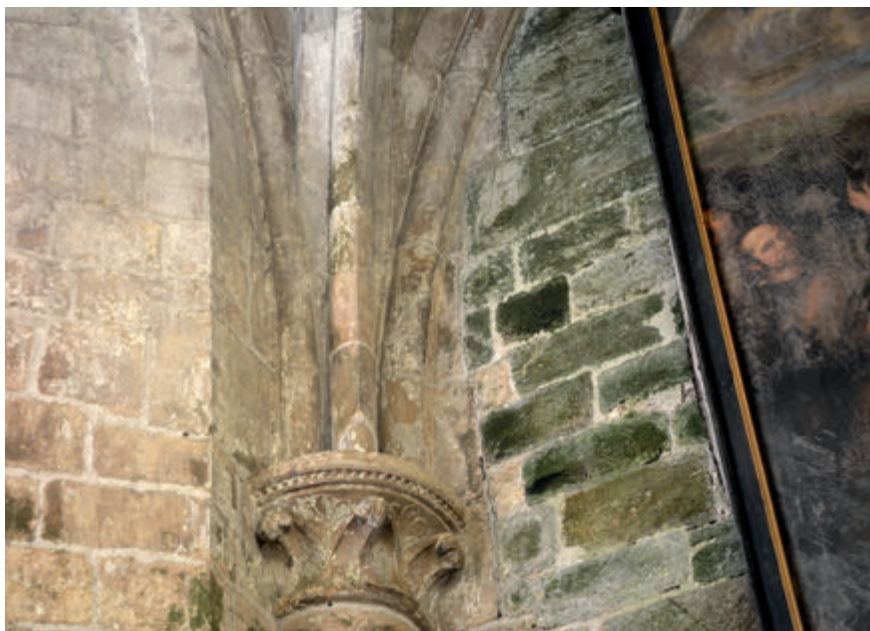
Figure 17 – Tréguier, cathédrale, angle ouest du bas-côté sud de la nef (cl. A. Ybert)
