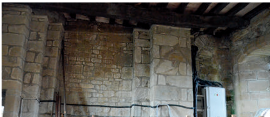
Figure 12 – Tréguier, cathédrale, vue de la face nord de la tour Hastings depuis la salle située au-dessus de la sacristie (cl. A. Ybert)
