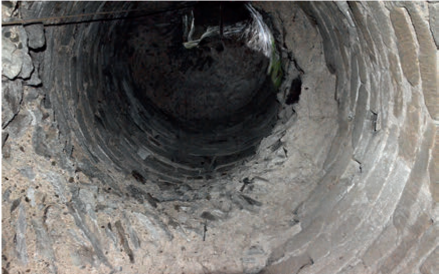
Figure 8 – Tréguier, cathédrale, tour Hastings partie terminale de l'escalier (cl. A. Ybert)
