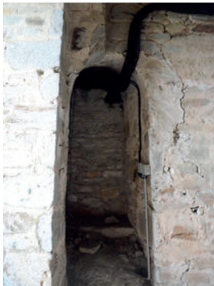
Figure 6c – Tréguier, cathédrale, salle médiane de la tour Hastings face sud-est (cl. A. Ybert)
