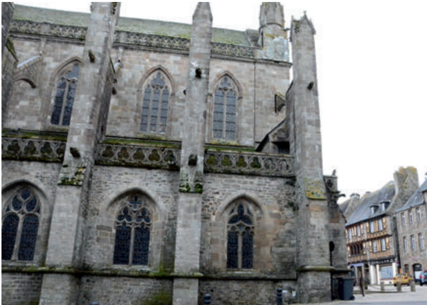
Figure 22 – Tréguier, cathédrale, trois premières travées occidentales de la nef côté nord (cl. A. Ybert)
