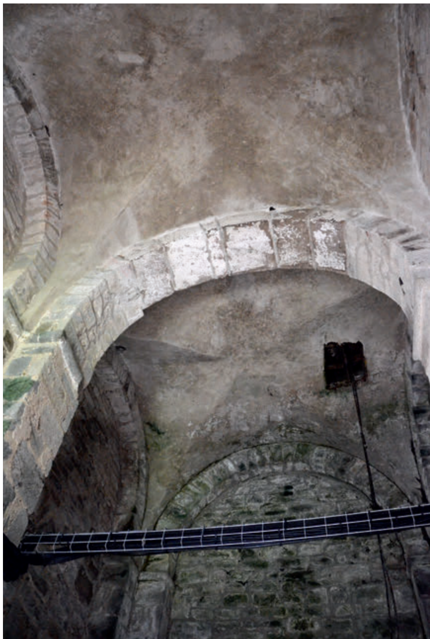
Figure 5 – Tréguier, cathédrale, salle médiane de la tour Hastings vue vers l'ouest (cl. A. Ybert)
