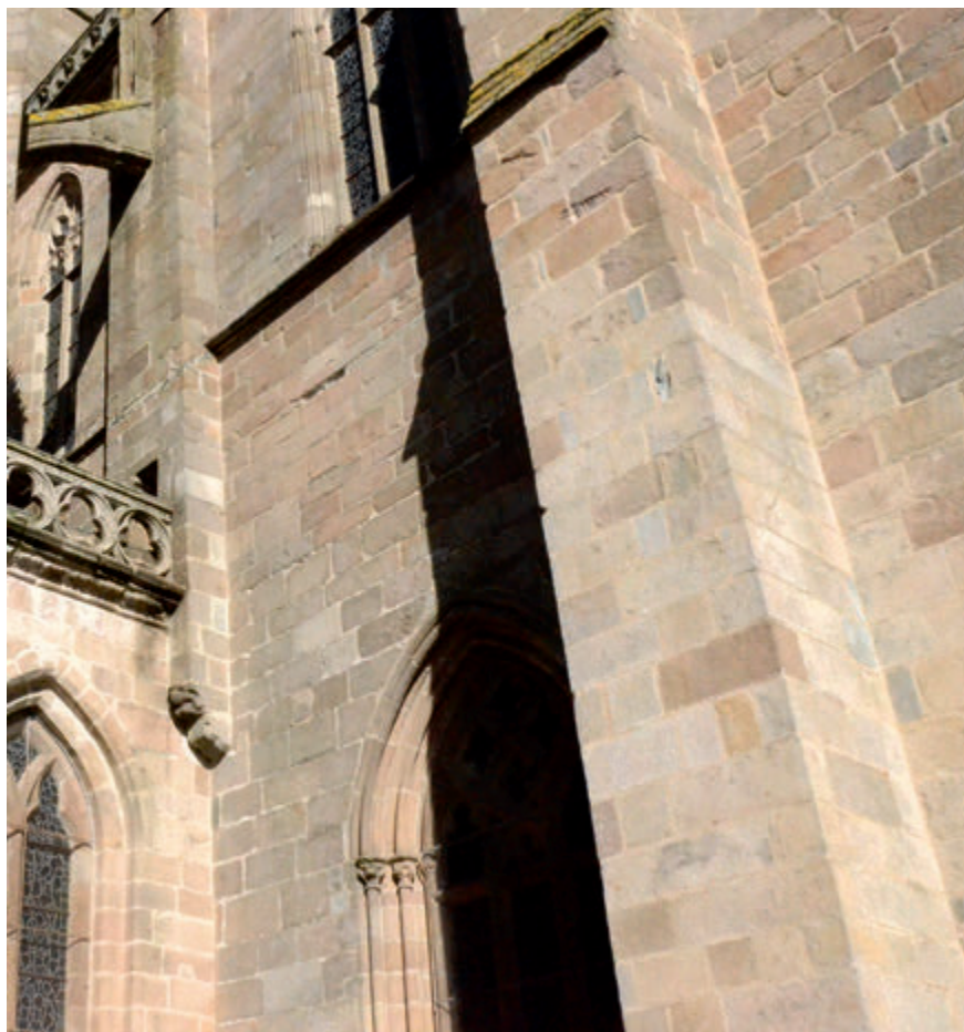
Figure 29 – Tréguier, cathédrale, mur occidental du bras sud traces de solin (cl. A. Ybert)
