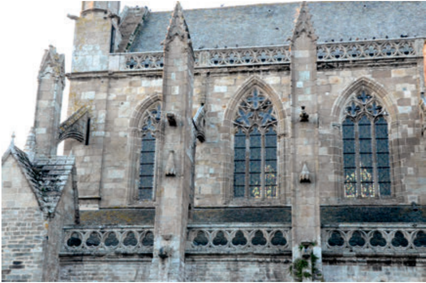
Figure 21 – Tréguier, cathédrale, mur gouttereau des trois premières travées de la nef côté sud (cl. A. Ybert)
