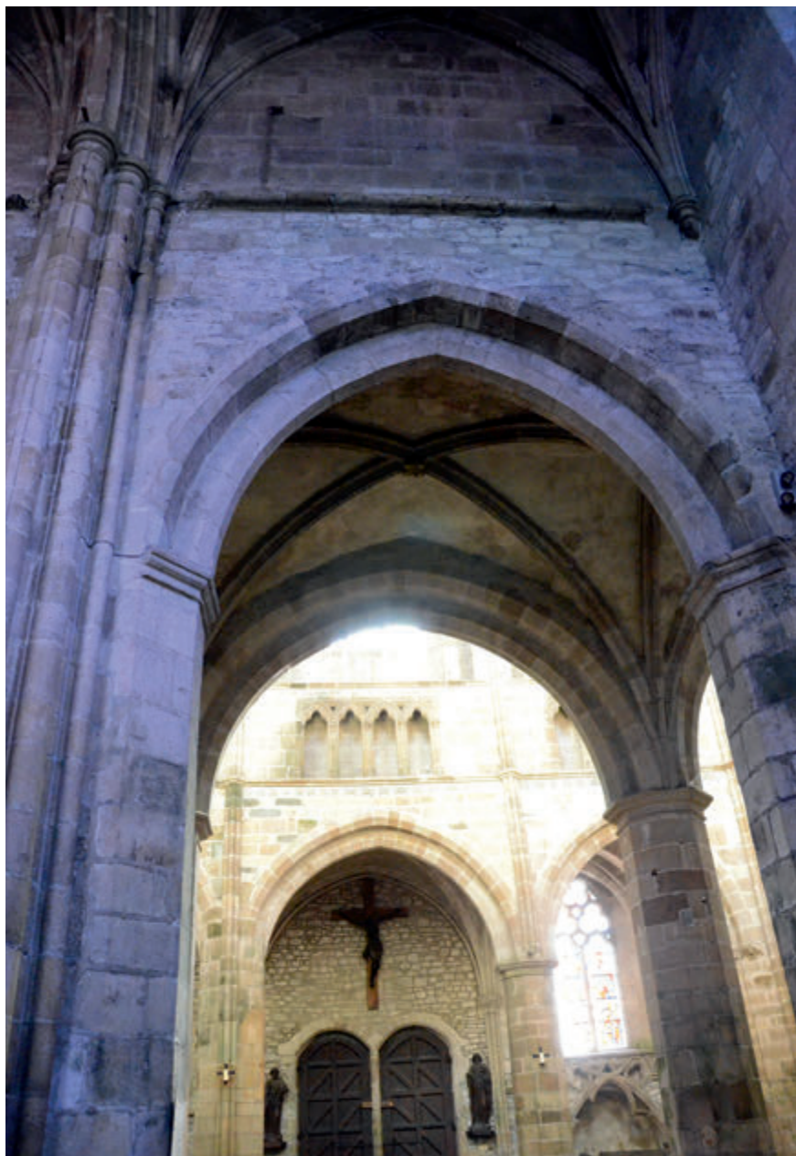
Figure 15 – Tréguier, cathédrale, première travée de la chapelle dite du duc depuis le nord (cl. A. Ybert)
