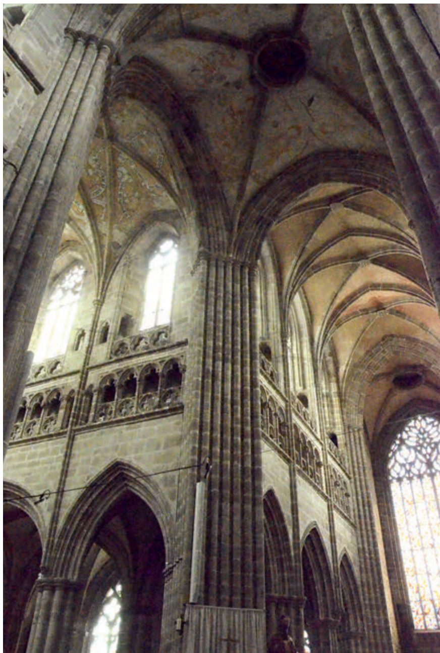
Figure 27 – Tréguier, cathédrale, élévation orientale du bras nord du transept (cl. A. Ybert)
