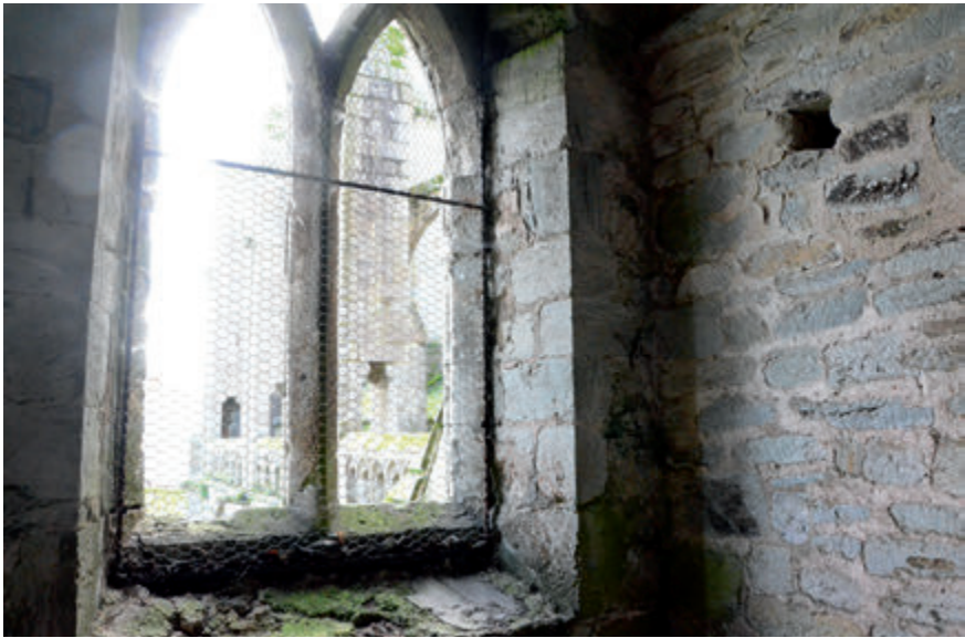
Figure 6b – Tréguier, cathédrale, salle médiane de la tour Hastings vue de la baie orientale (cl. A. Ybert)
